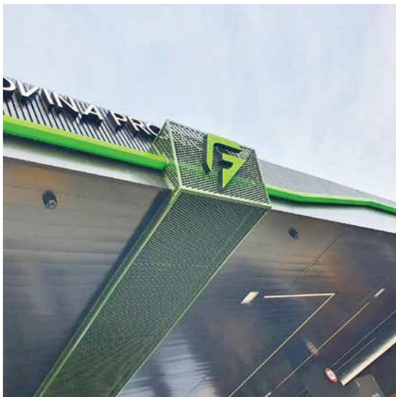
Lokacija: Mostar Projekat Pumpe
